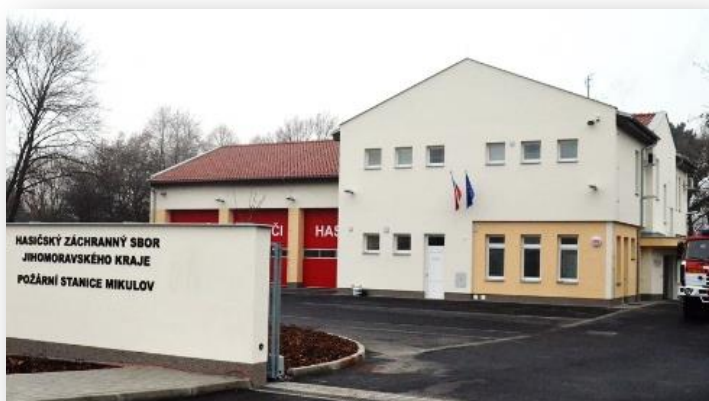
Nová budova zbrojnice v Mikulově
