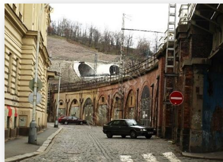
Negrelliho viadukt v Karlíně
